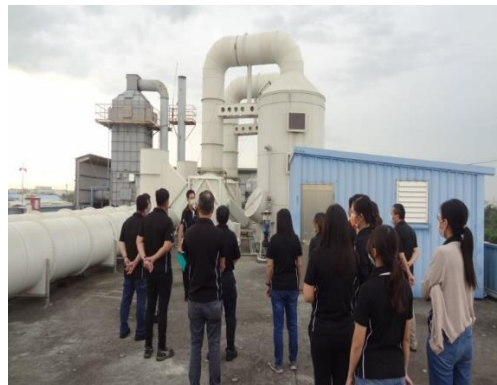
電鍍空污設備解說
